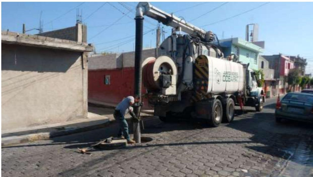
La limpieza y desazolve de las redes de alcantarillado sanitario, es un tema de importancia para todos los ciudadanos, ya que una red de drenaje obstruida o azolvada crean graves problemas que afectan la eficiencia de la tubería de descarga sanitaria, además de generar riesgos para la salud pública.
